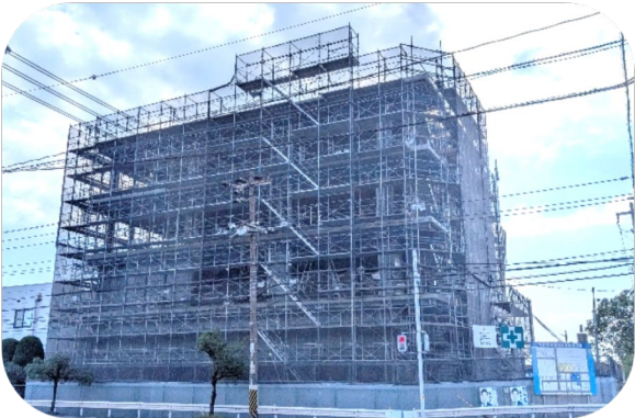
金属管理技術関連設備を設置する 新事務棟（25年11月現在）
