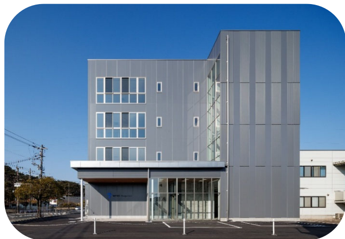
微量金属分析装置を設置する 新事務所棟 (2026年5月現在)
